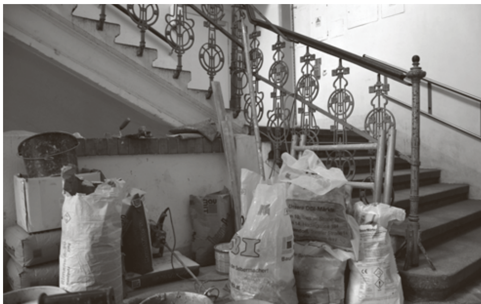
In der Stiege 4 beginnen die Arbeiten Foto Maria Bergstötter
