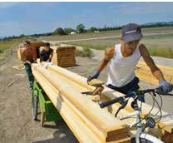
Für die Transporte in aspern Seestadt gelangten bei greenlab selbst gebaute Lastenfahräder zum Einsatz, um die Distanzen vom Lagerplatz zu den Baustellen möglichst nachhaltig überwinden zu können.
